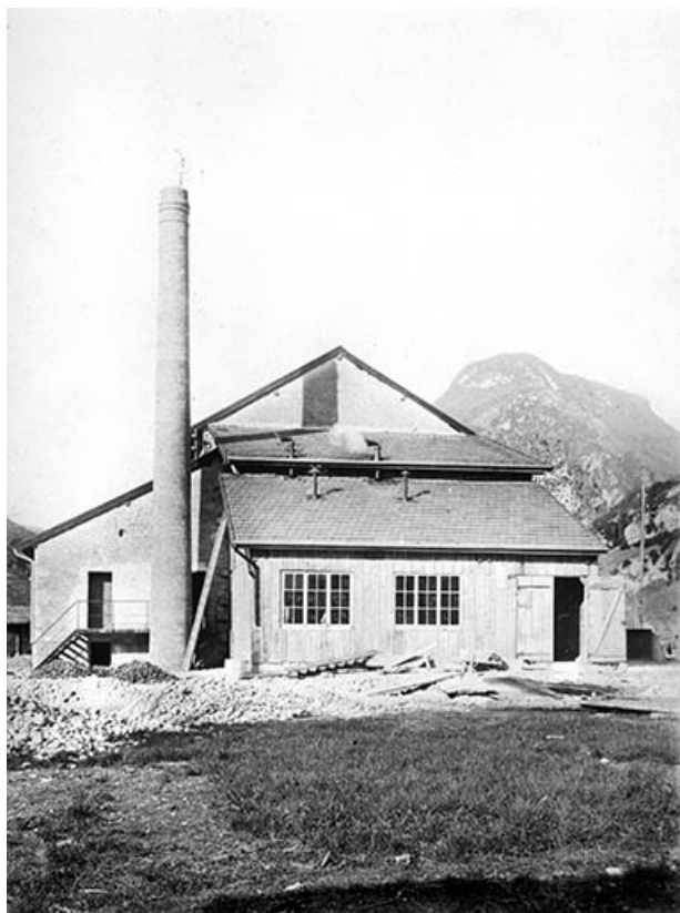
Producer House, annexe and Chimney [Atelier de fabrication, annexe et cheminée en 1910]. 39, Saint-Claude, 11, 26, 28, 32, 34 rue Saint-Blaise
