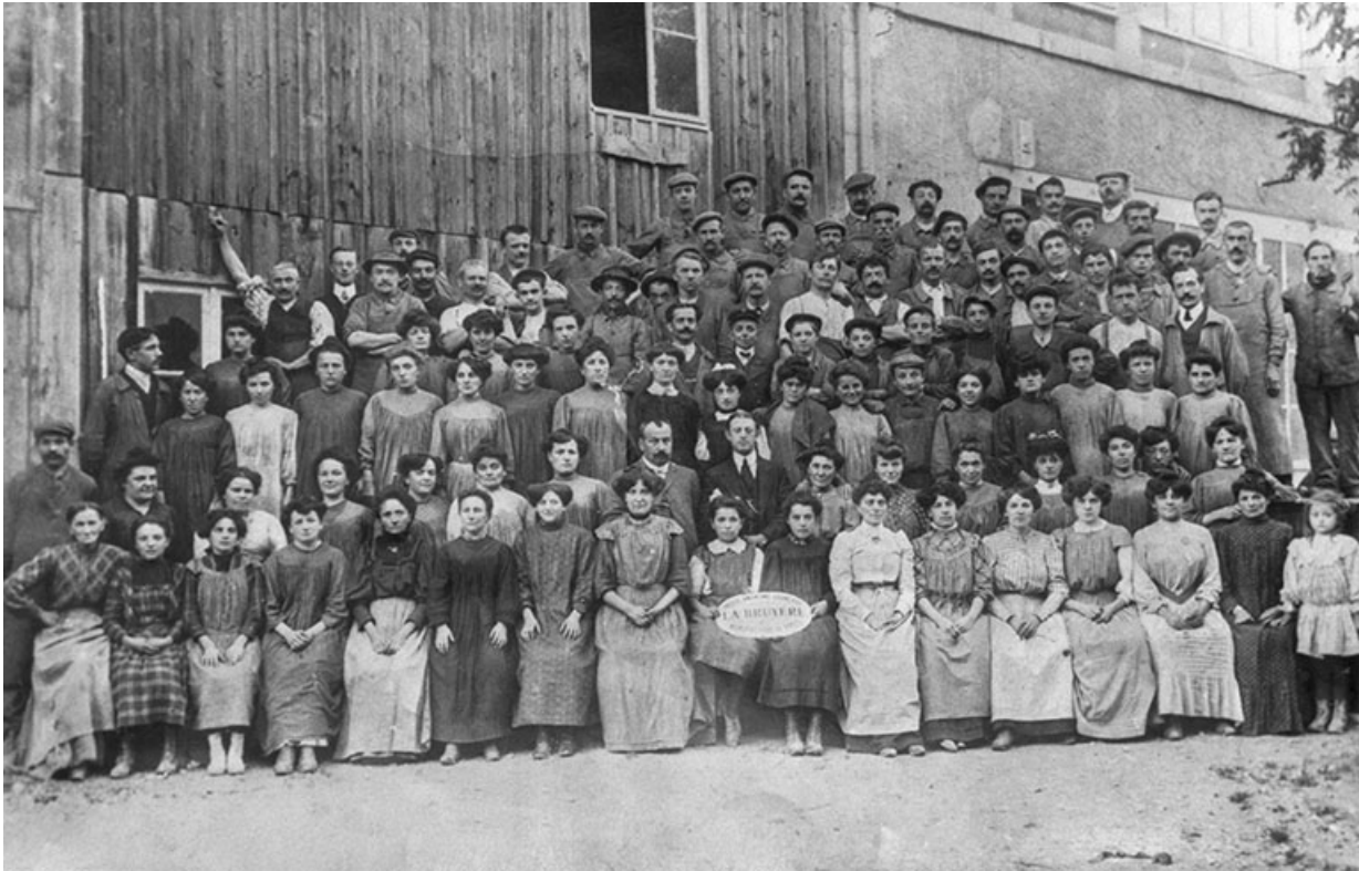
[Le personnel de l'usine].
