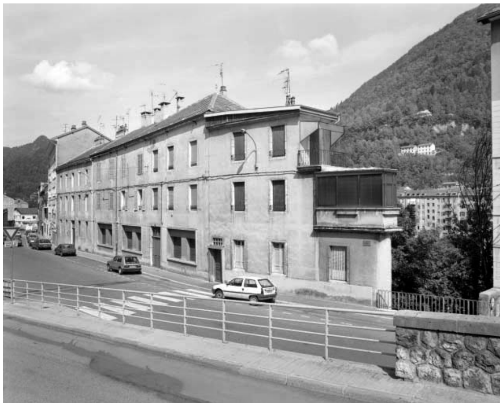
Vue d'ensemble des immeubles n° 22 et 24 (bureau, magasin industriel, boutique et logements). 39, Saint-Claude, 22 à 25 avenue de la Gare
