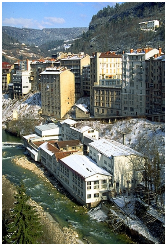
Vue plongeante depuis le sud-ouest.
