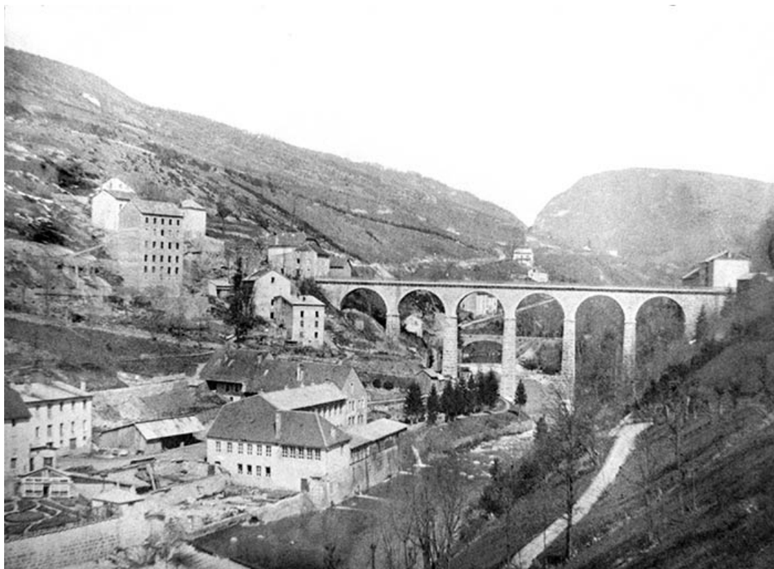
[Vue d'ensemble de l'usine et du Pont de pierre depuis le sud-est].
