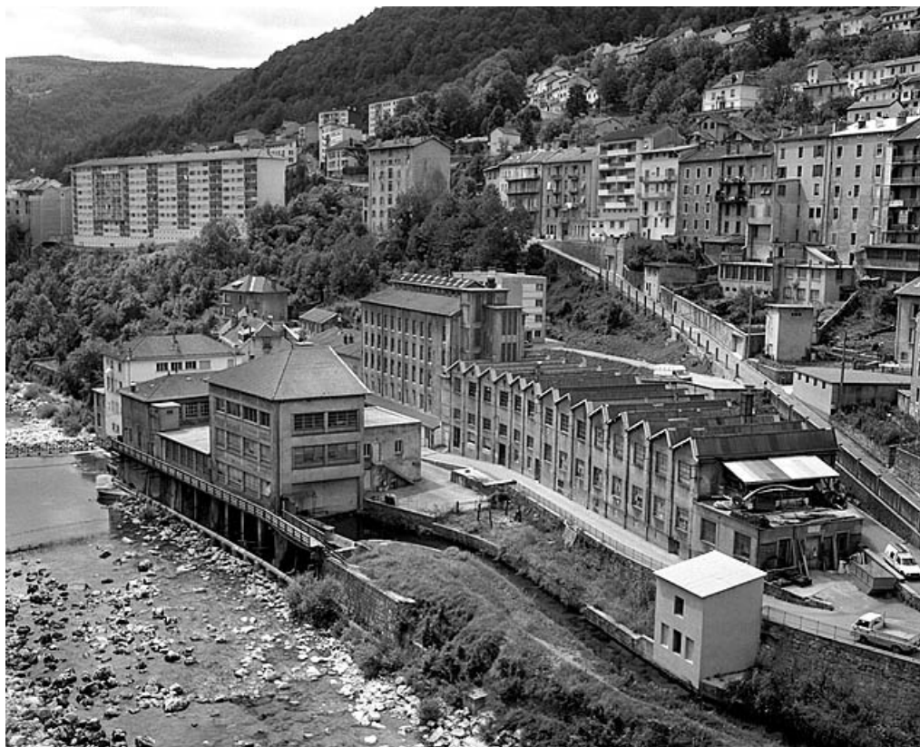
Vue d'ensemble du site depuis le nord-est.
