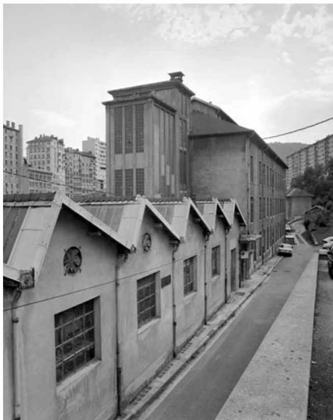
Cristallerie Dalloz : façade antérieure de trois quarts gauche. 39, Saint-Claude, 1 à 23 rue de la Papeterie
