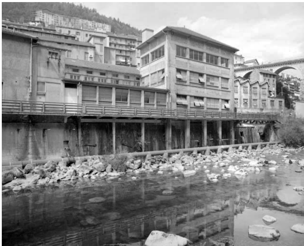
Diamanterie Dalloz : partie droite de la façade postérieure.
