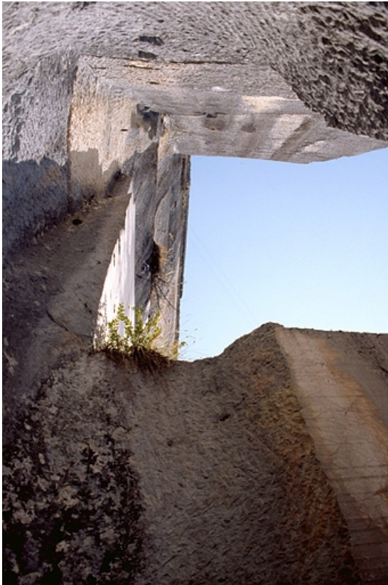
Carrière, partie nord : tranchée et puits pour le passage du fil hélicoïdal, vus du dessous. 39, Pratz, lieudit : Champied
