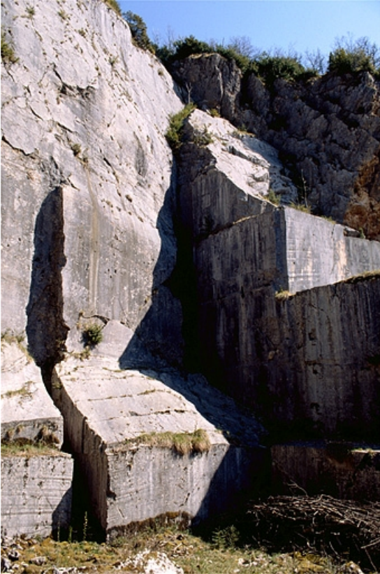
Carrière, partie nord : front de taille depuis l'intérieur de la fosse.
