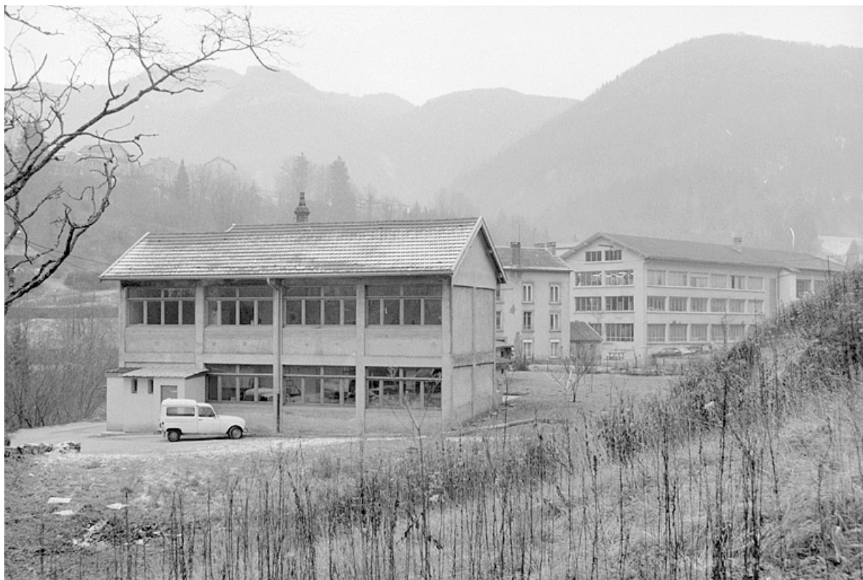
Façade latérale de l'atelier de fabrication.
