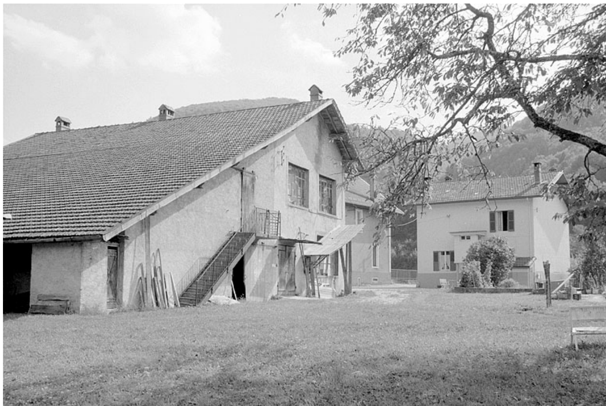
Façade latérale gauche de l'atelier et façade postérieure du logement patronal. 39, Vaux-lès-Saint-Claude
