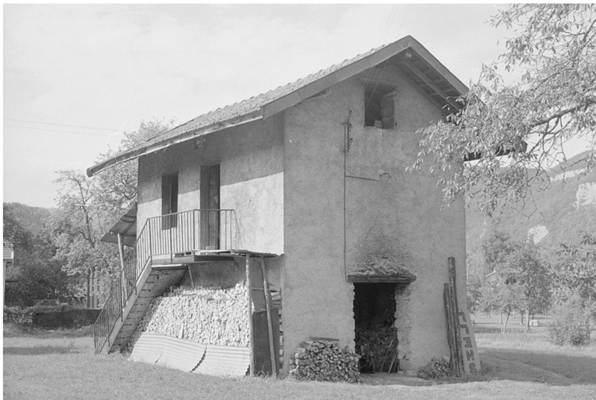
Bâtiment du four et du logement d'ouvriers.
