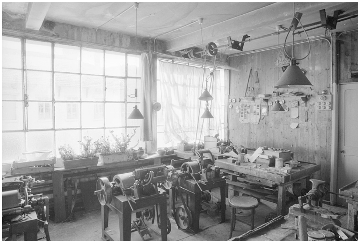
Intérieur de l'atelier de fabrication.
