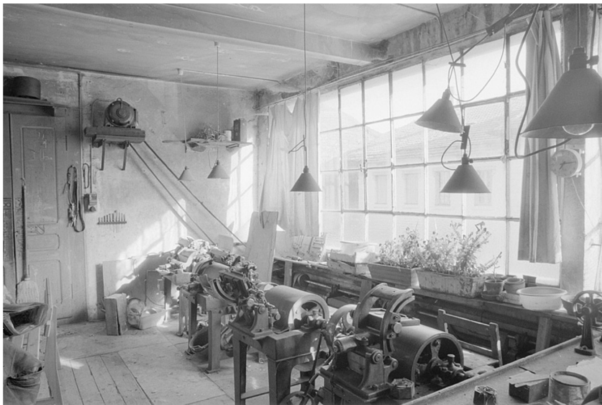
Intérieur de l'atelier de fabrication.
