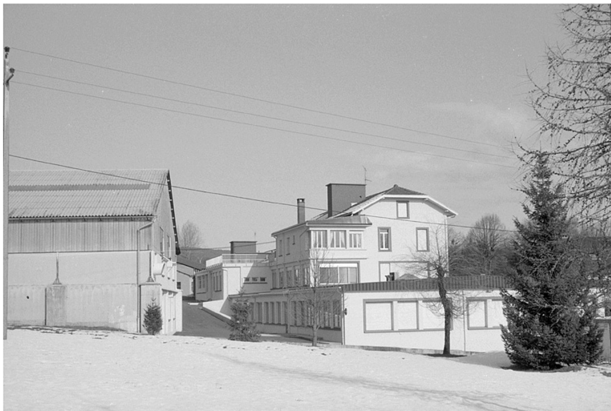
Façade postérieure des bureaux et du logement patronal.
