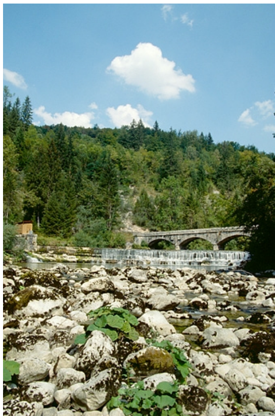
Le barrage, vu de l'aval.
