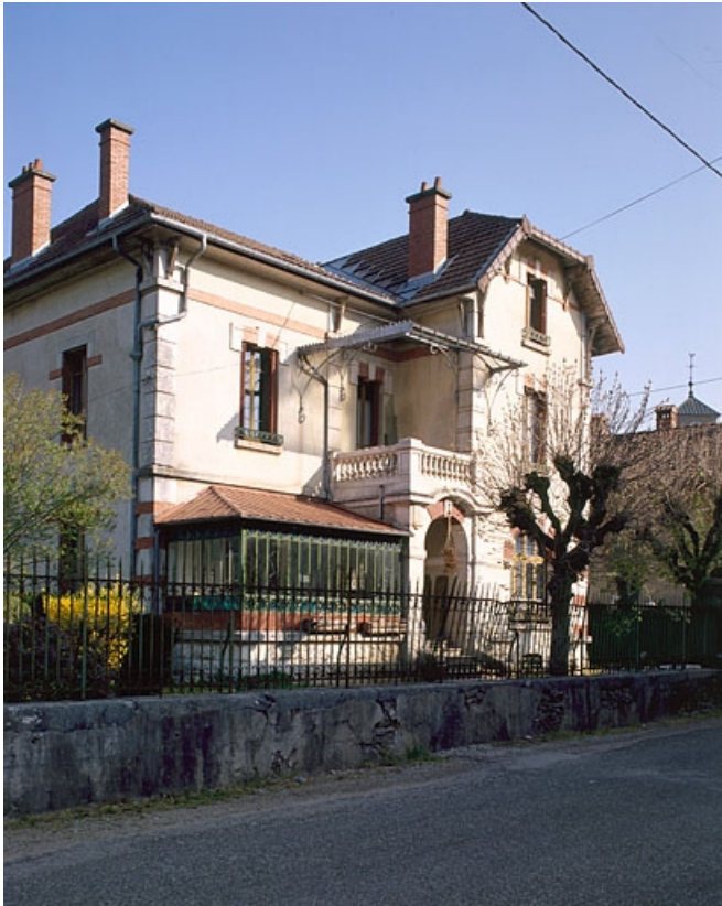
Vue d'ensemble de la façade antérieure, de trois quarts gauche. 39, Molinges
