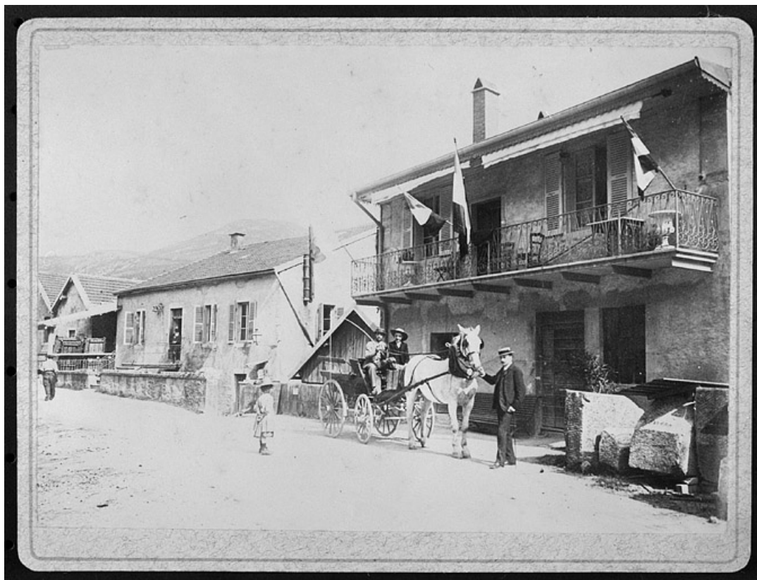
Attelage devant des ateliers et logement.
