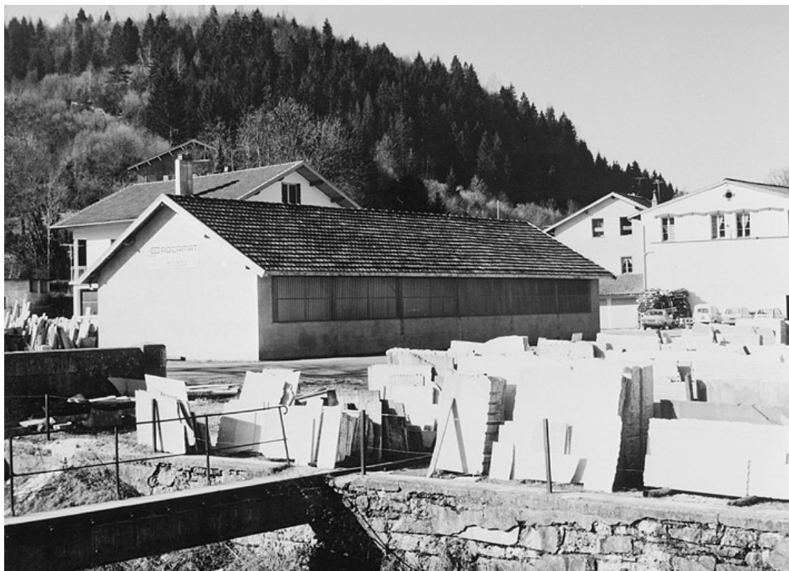
Aire des matières premières et magasin industriel.
