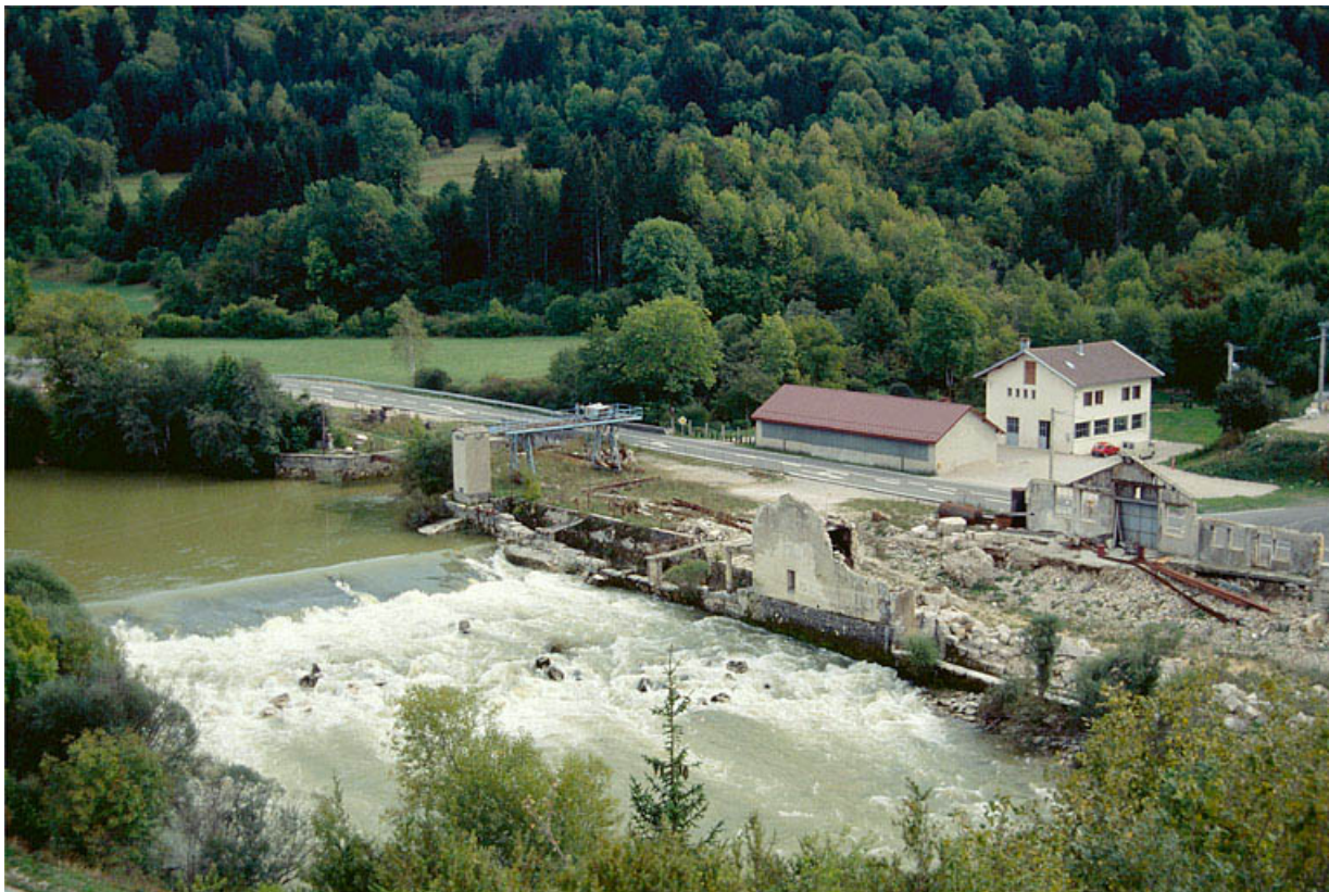
Vue d'ensemble plongeante depuis le nord.
