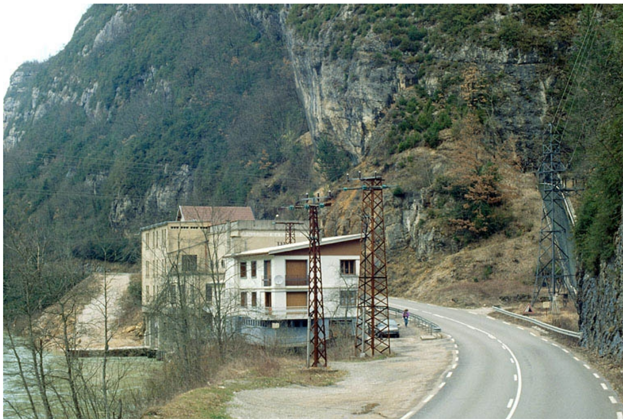
Vue d'ensemble : logement d'ouvriers et centrale.
