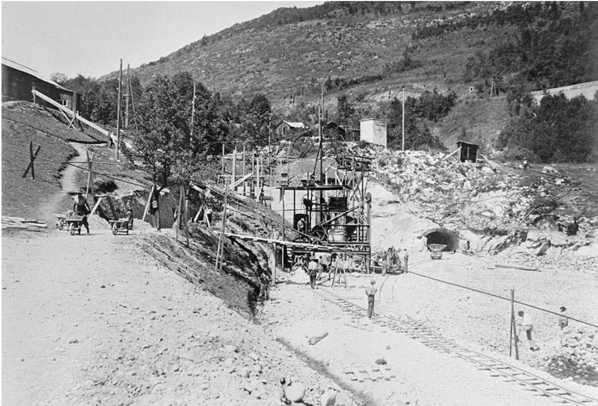
Chantier du barrage. Poste de transformation et compression d'air n° 1. Mur de rive de la prise d'eau. Chantier de concassage et de broyage et bétonnière. Alimentation d'eau et magasin des chaux et de ciment.
