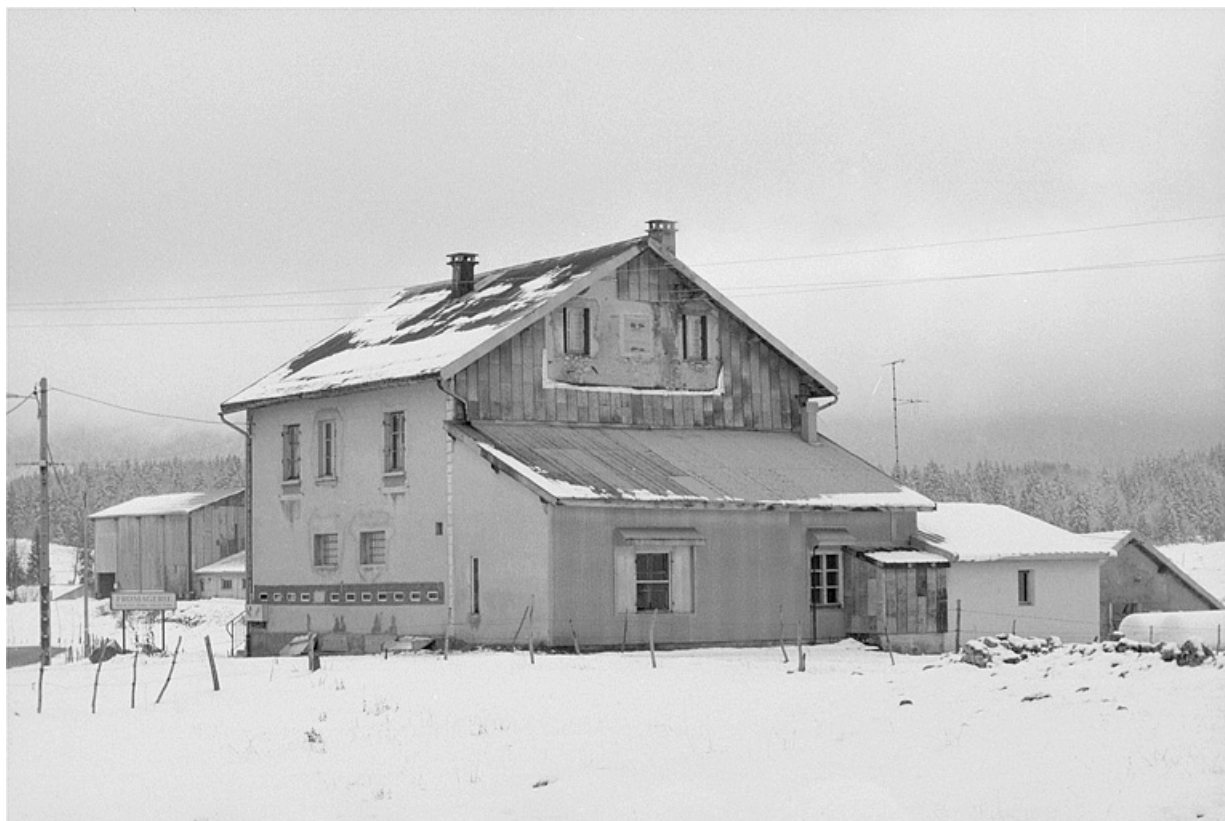
Fromagerie : façades postérieure et latérale droite. 39, Lajoux
