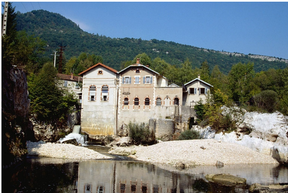
Vue d'ensemble depuis la rive gauche de la Bienne.
