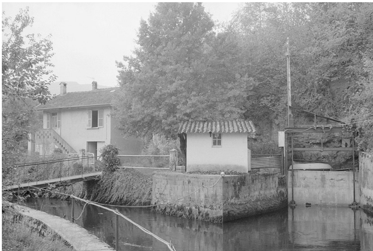
Bifurcation du canal d'amenée. À gauche vers les 2 turbines Francis, à droite vers la turbine Kaplan.
