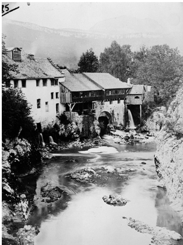
Façade de la scierie et du moulin sur la Bienne.
