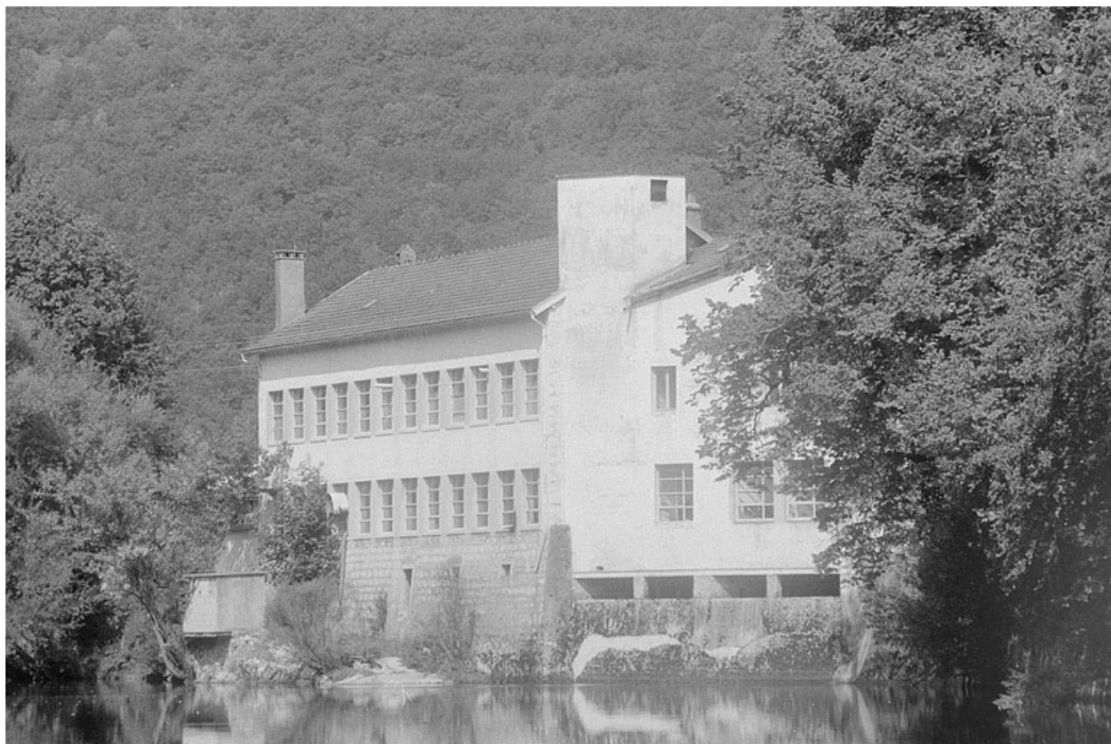
Atelier de fabrication, depuis le sud-est (amont).
