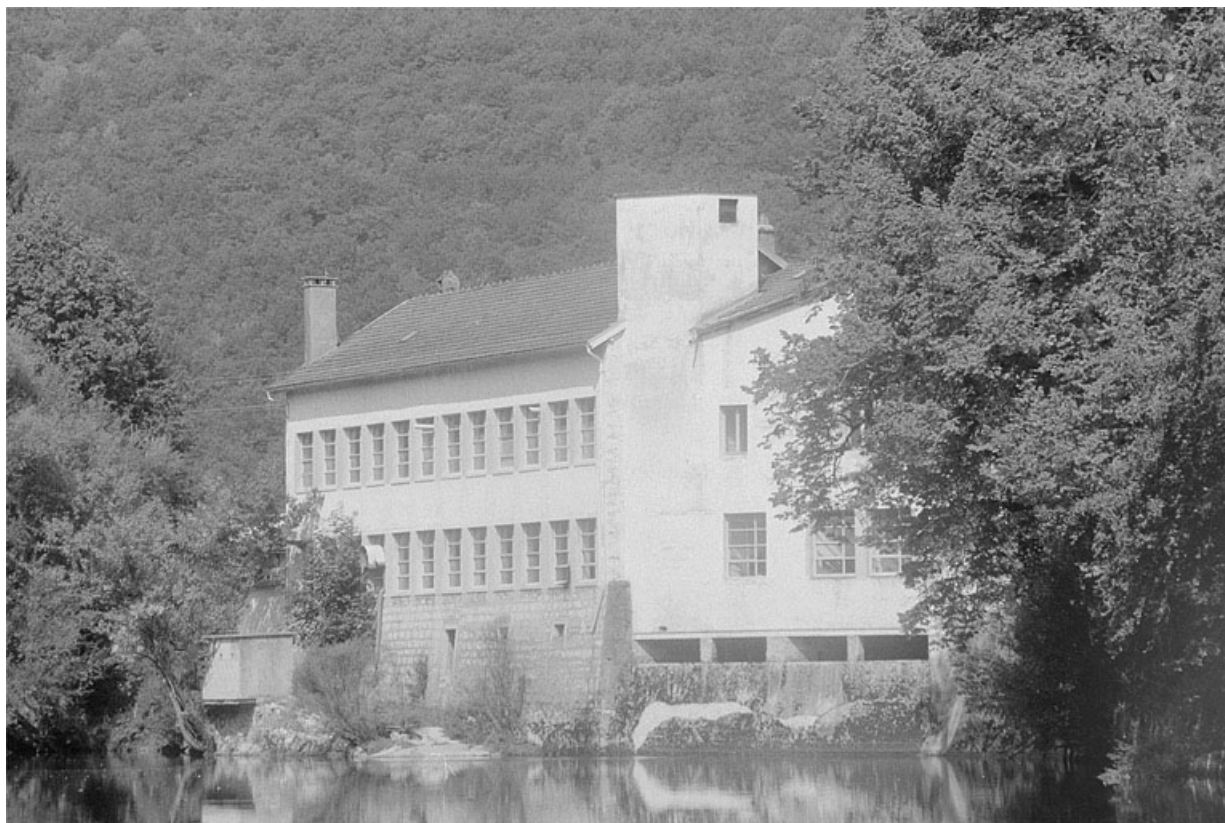
Atelier de fabrication, depuis le sud-est (amont).
