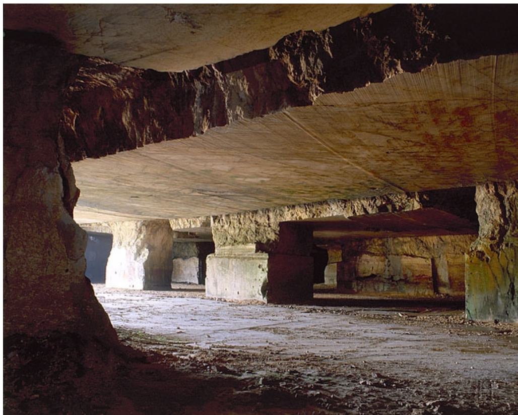
Intérieur, partie centrale, près d'une entrée.
