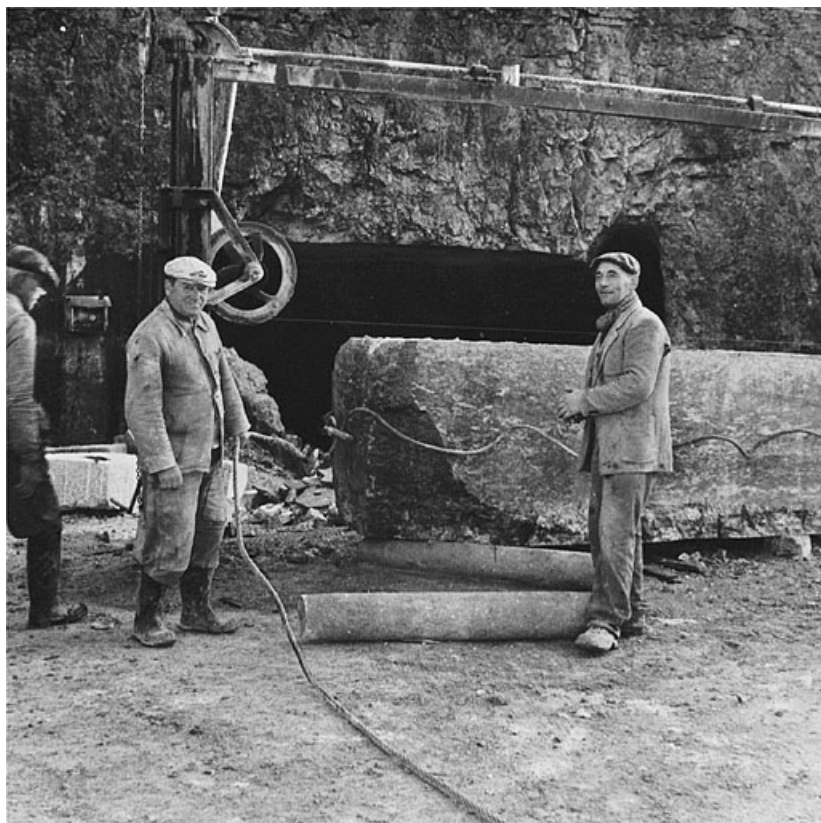
Tirage d'un bloc sur le chantier : mise en place du cable.
