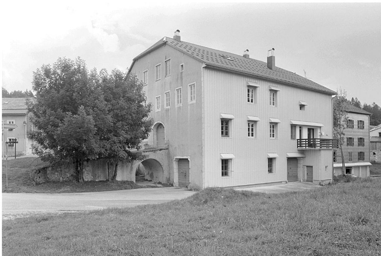
Façade postérieure et face nord-ouest.
