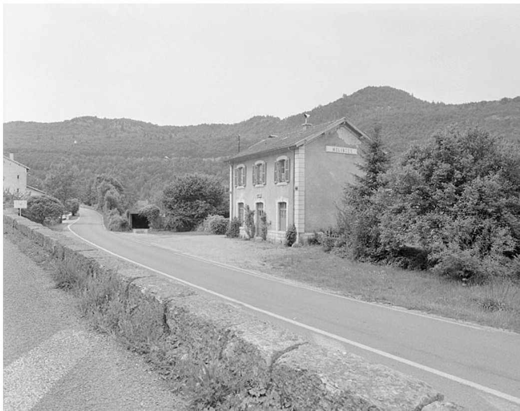
Vue d'ensemble, depuis la route de Lyon (est).
