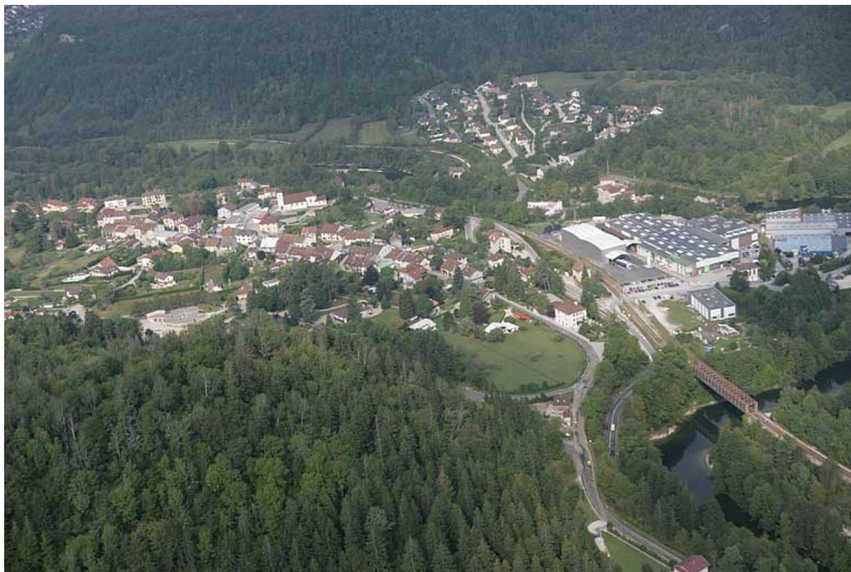
Vue aérienne du village, depuis l'est. 39, Molinges
