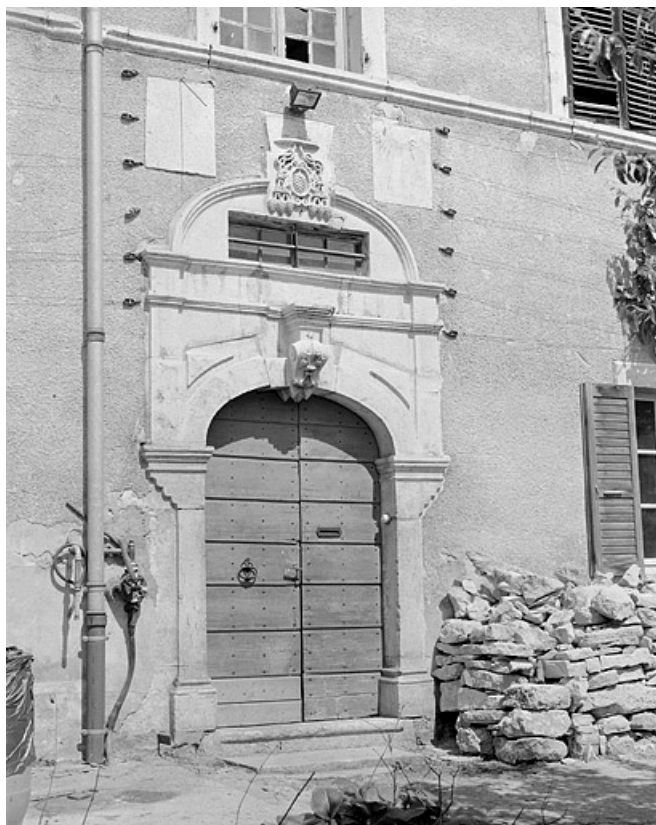
La porte d'accès de la façade antérieure.
