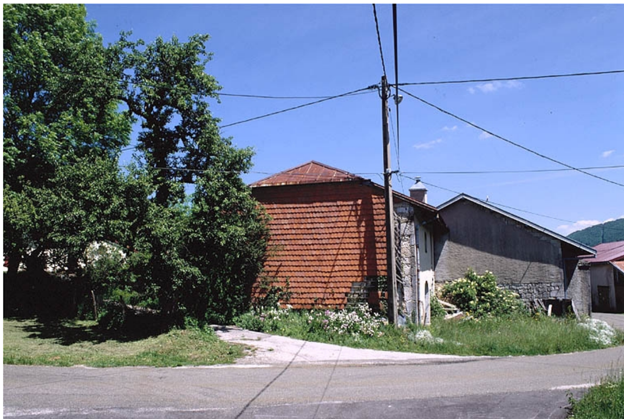
Vue de la façade comportant un essentage de tuiles.
