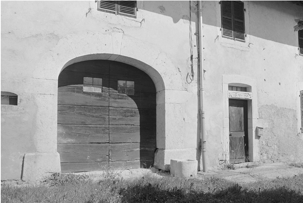
Porte de grange et accès au logis.
