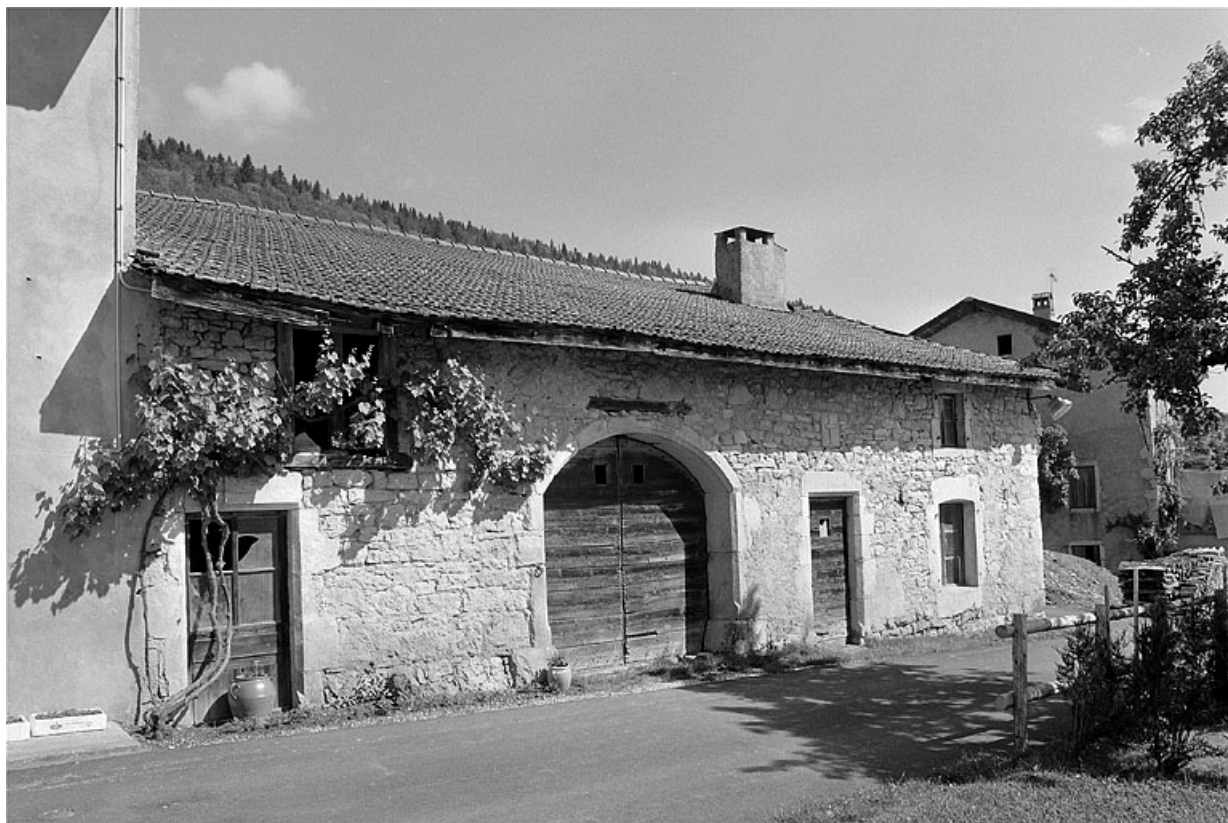
Ferme à trois travées : étable, grange, logis.
