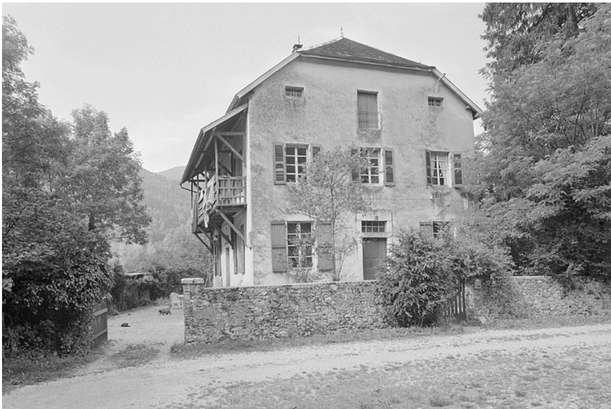
Vue générale de la façade antérieure. 39, Vaux-lès-Saint-Claude
