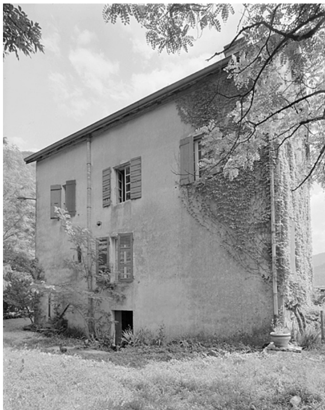
Façade droite avec accès au sous-sol.
