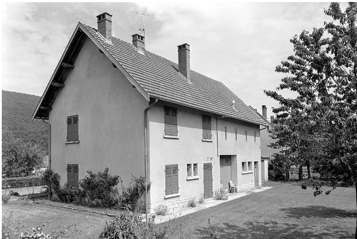
Vue de trois quarts de la façade antérieure et de la face gauche.
