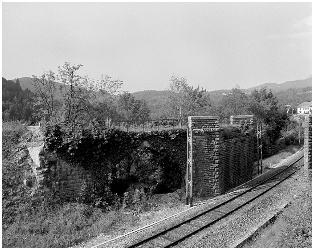
Ruines du pont du tramway enjambant la voie ferrée de Saint-Claude à Clairvaux-les-Lacs, à Lizon.
