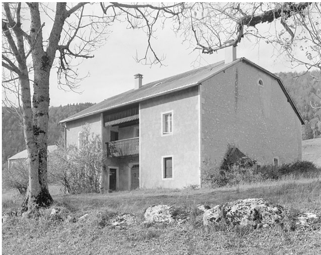
Façade antérieure et face nord-est.
