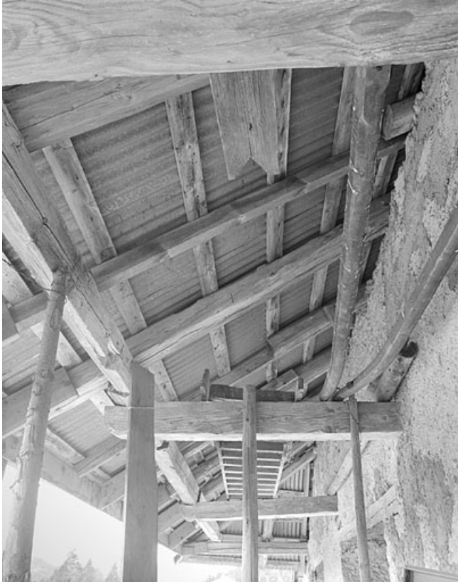
Détail de la charpente de l'avant-toit.
