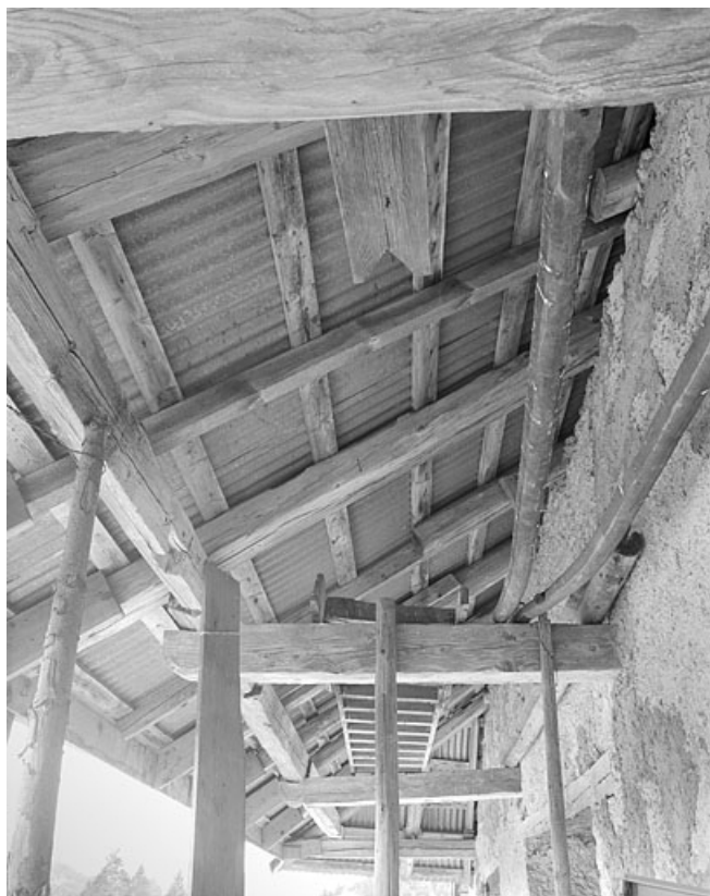
Détail de la charpente de l'avant-toit.
