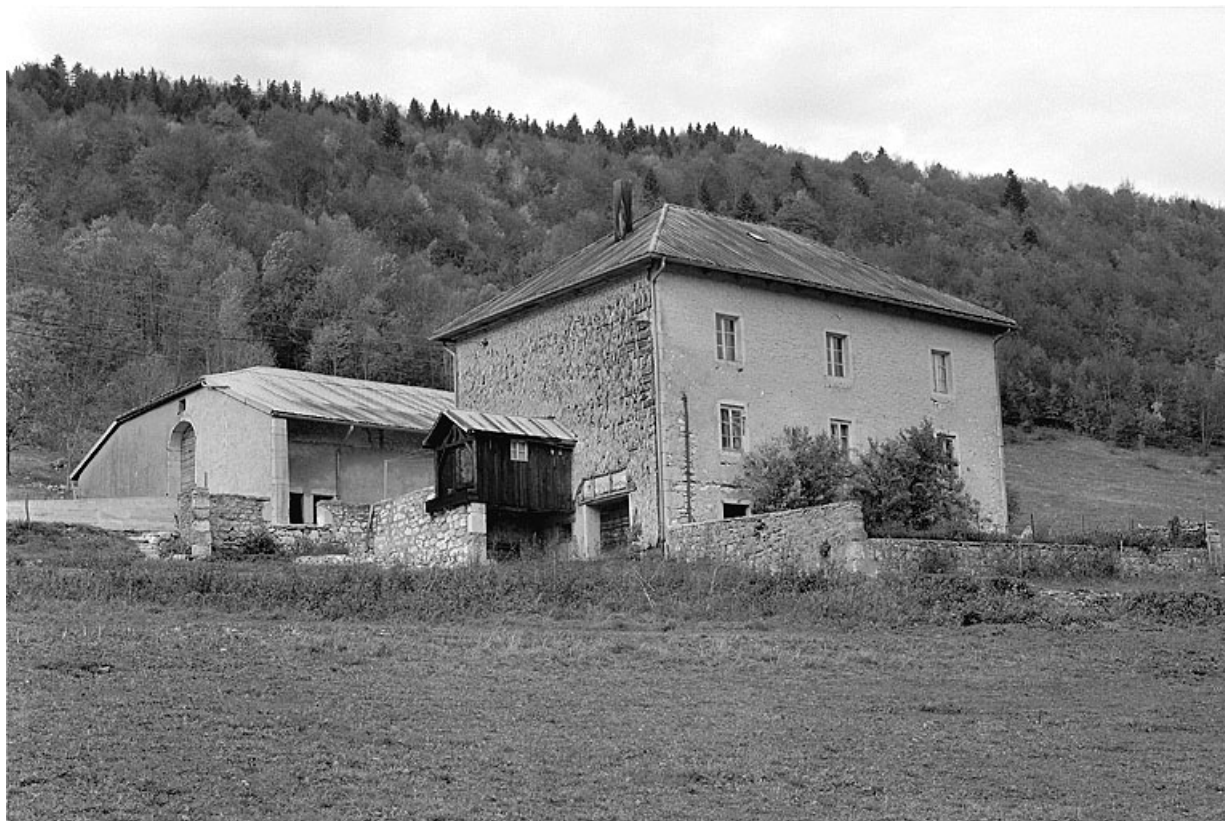
Face sud-ouest et façade postérieure.
