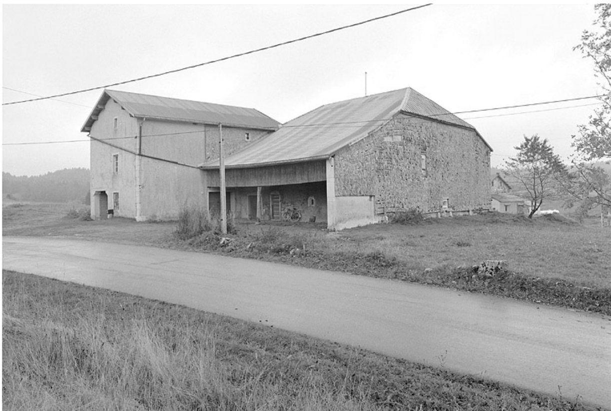
Façade postérieure et face ouest.
