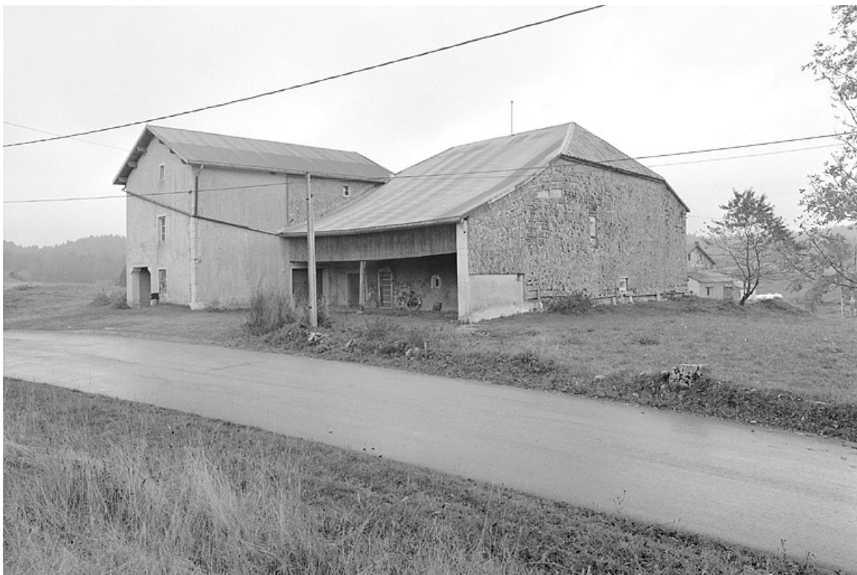
Façade postérieure et face ouest.
