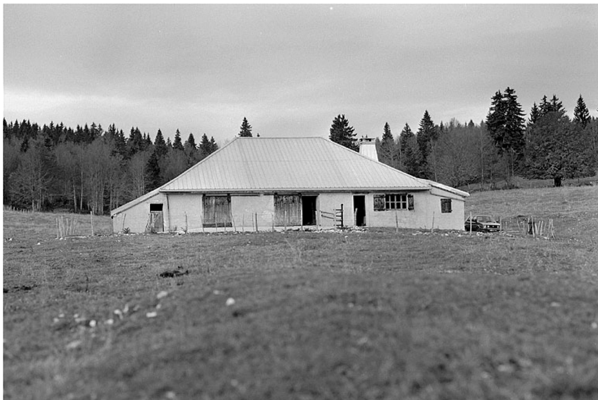
Façade antérieure du chalet d'estive de la Pièce d'Aval.
