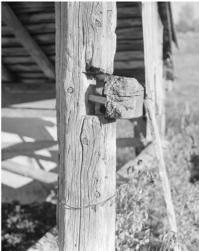
Assemblage à mi-bois poteaux-panne par une cheville. 39, Lajoux
