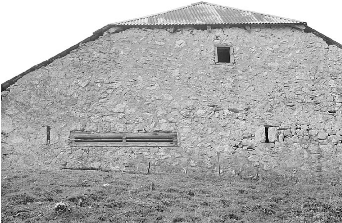
Ouverture en bois pour ventiler la laiterie.
