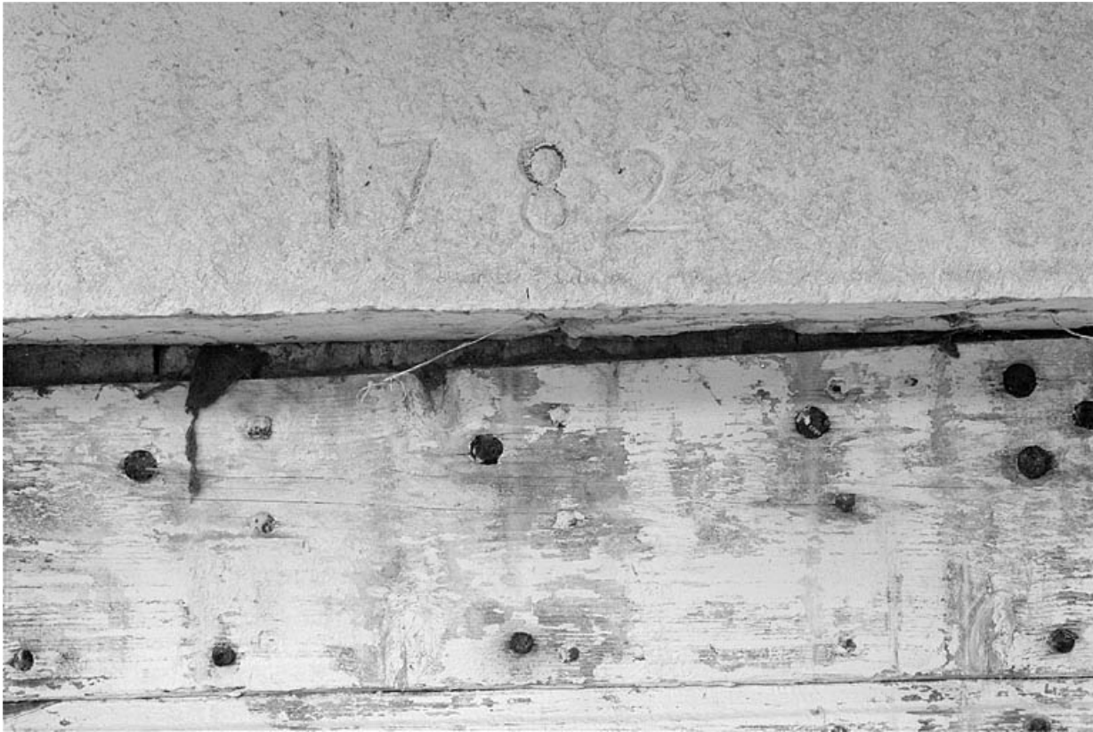
Date portée par l'entrée de l'étable sur la façade postérieure.
