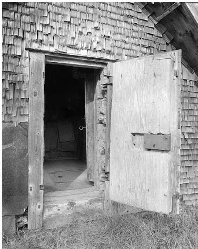
Les deux portes du grenier fort ouvertes.
