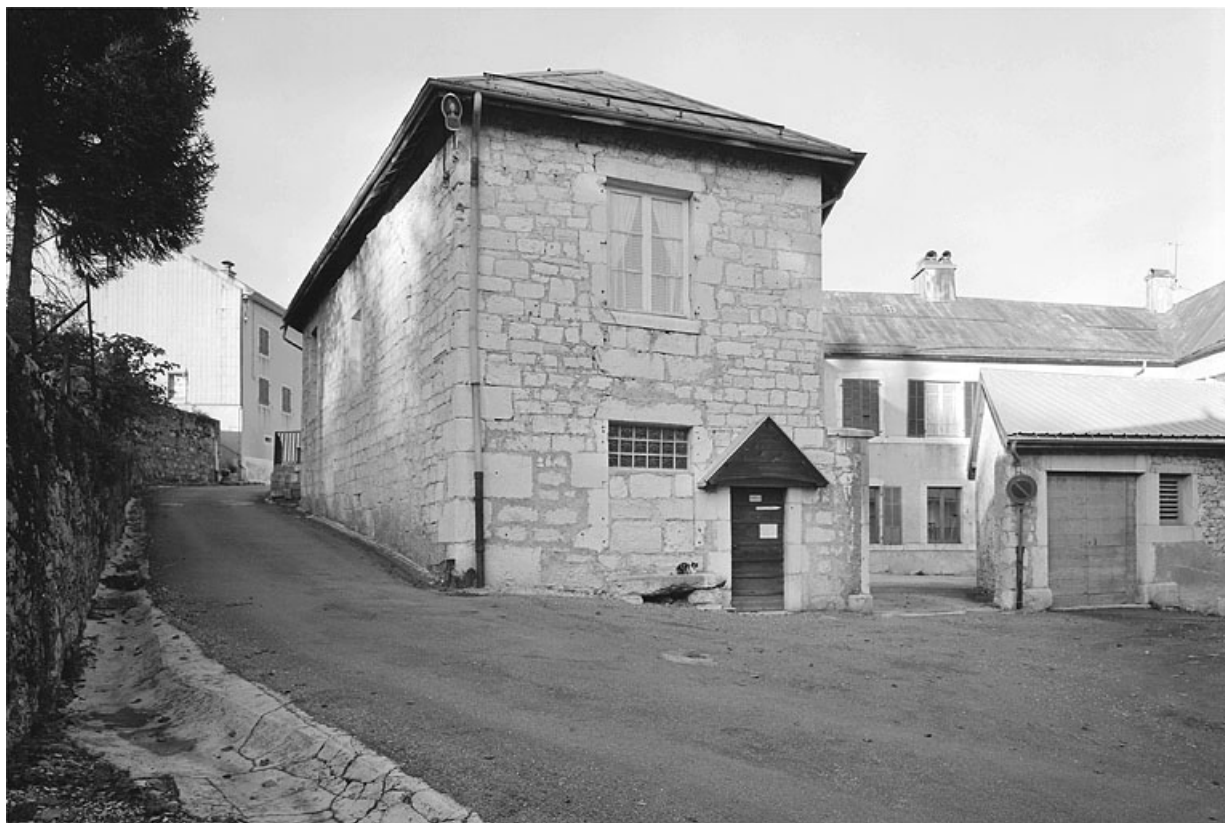
Vue générale, face sud-ouest.
