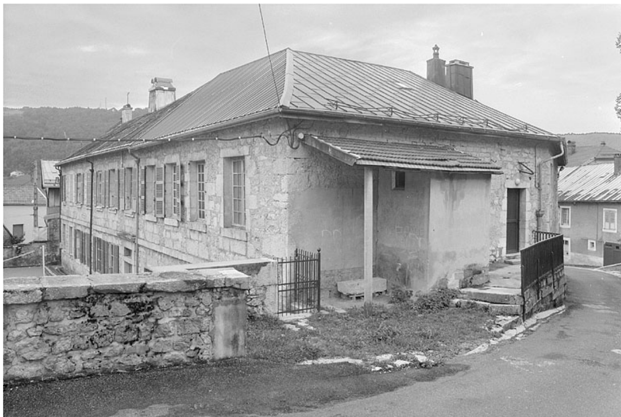
Façade postérieure et face ouest.
