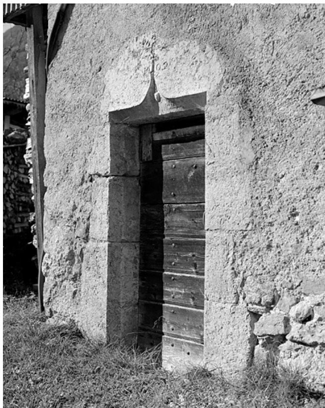
Porte avec accolade. 39, Villard-Saint-Sauveur
