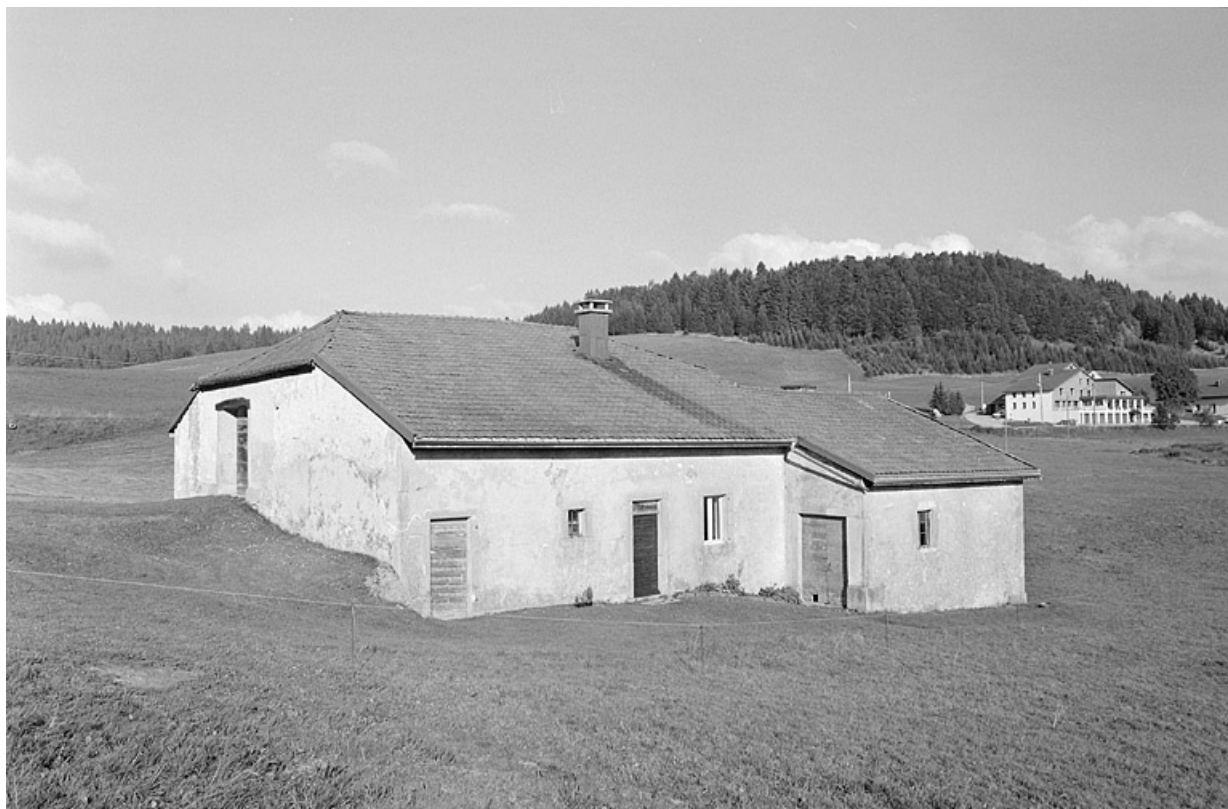
Façade antérieure et face nord-ouest.
