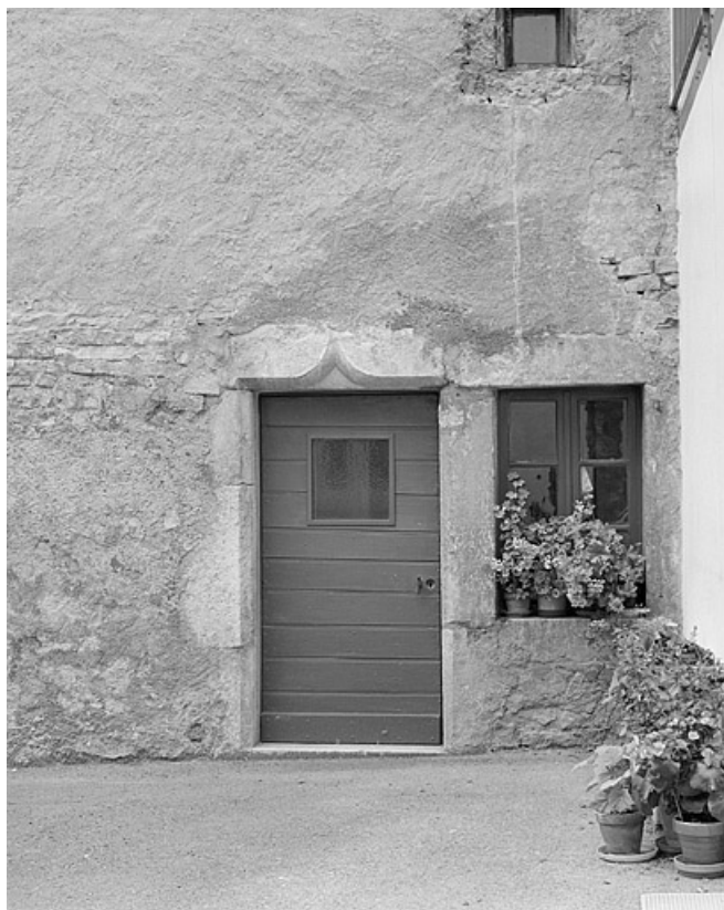
Porte d'accès avec linteau en accolade.
