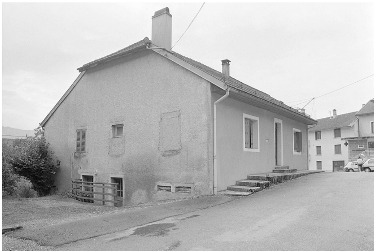
Ancienne maison commune de Lavans ayant abrité la fromagerie. 39, Lavans-lès-Saint-Claude
