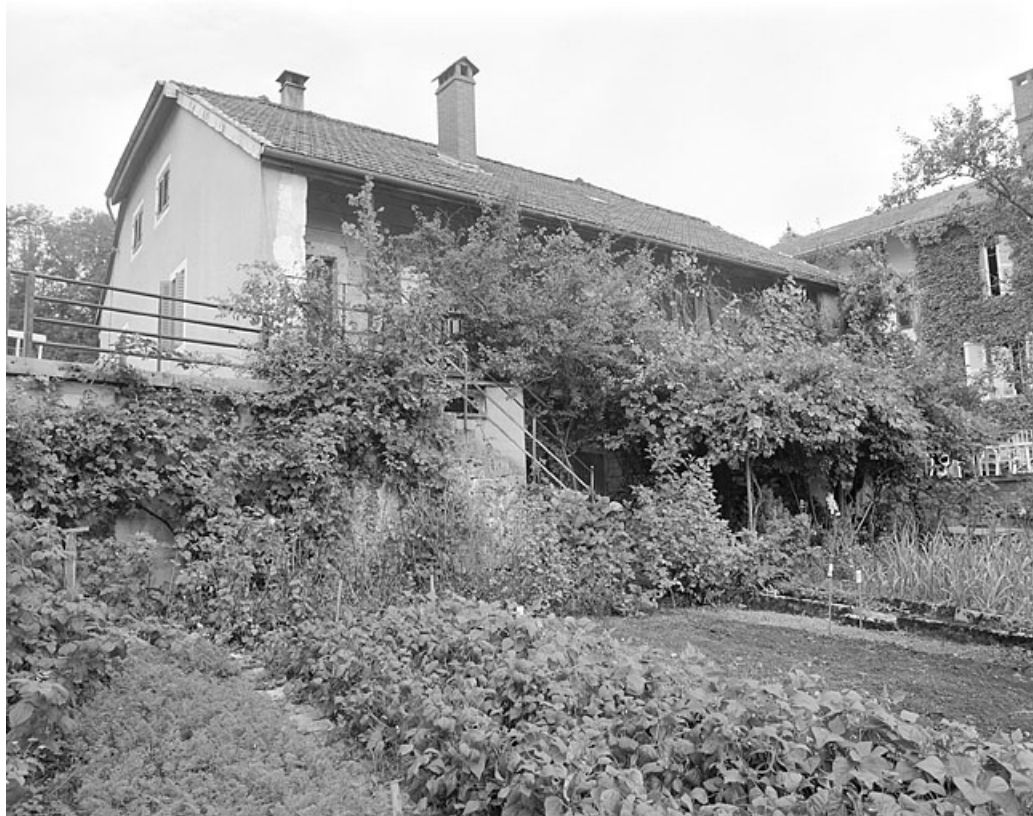
Façade postérieure de l'ancienne maison communale.
