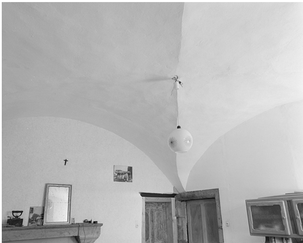
Pièce du rez-de-chaussée, voûte d'arêtes.
