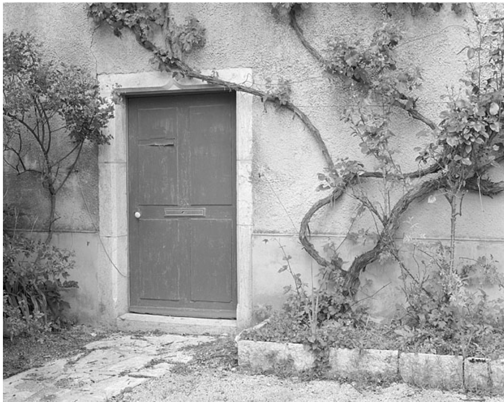
Façade antérieure, détail d'une porte. 39, Saint-Lupicin, 7 rue du Curé Marquis
