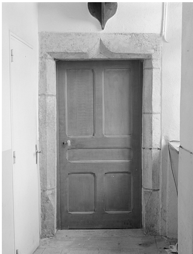
Porte intérieure avec linteau en accolade.
