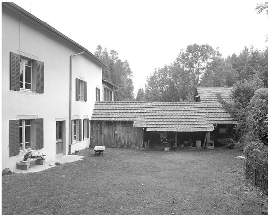
Bâtiment de la scierie perpendiculaire à la ferme.
