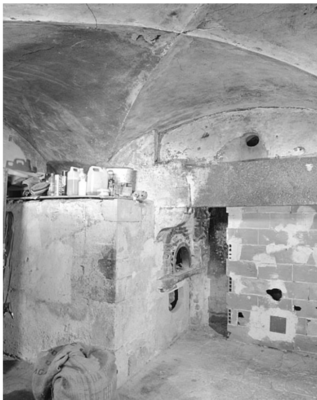
Ancienne cuisine voûtée avec cheminée et four au rez-de-chaussée. 39, Leschères Eglise
