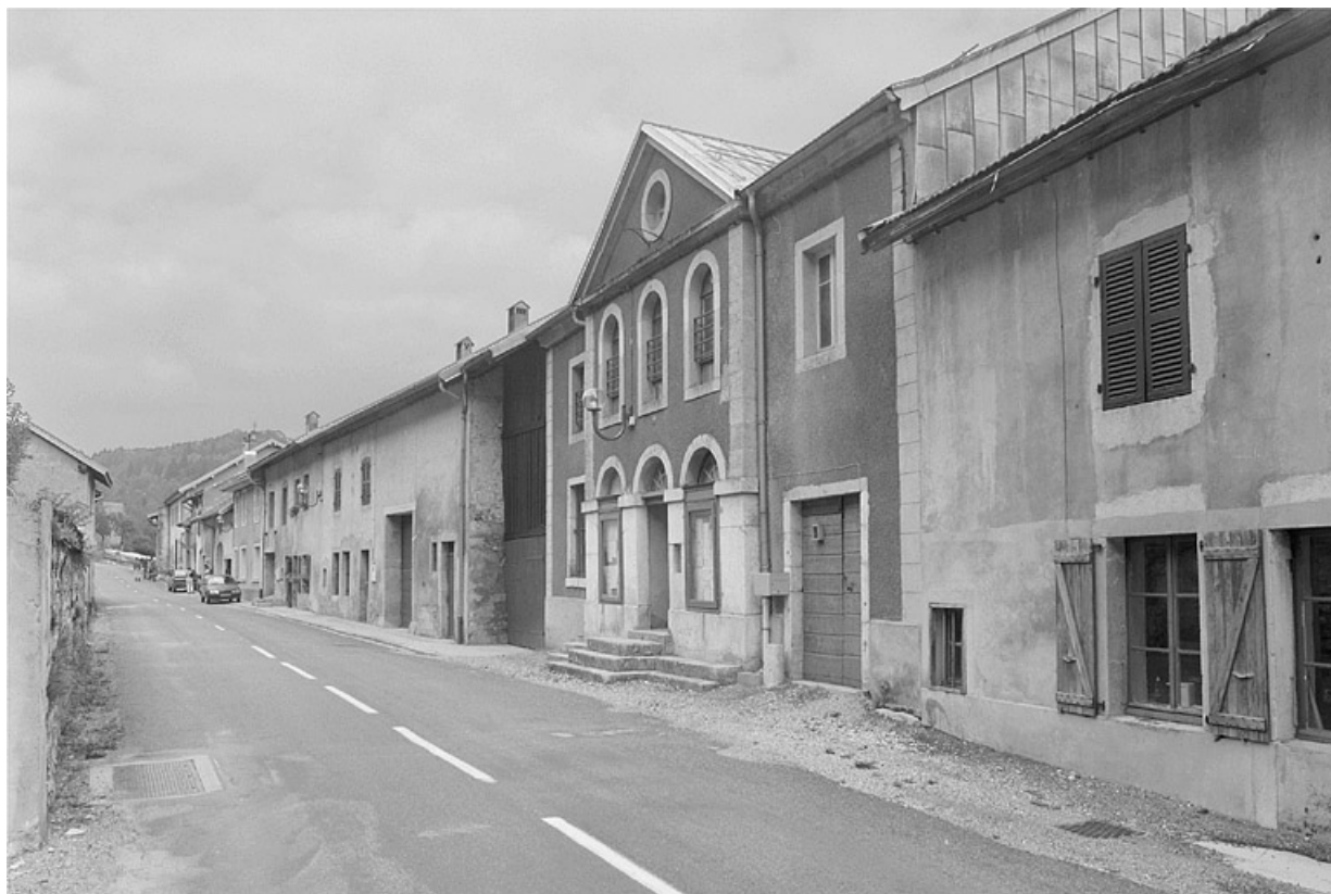
Vue depuis la rue principale.
