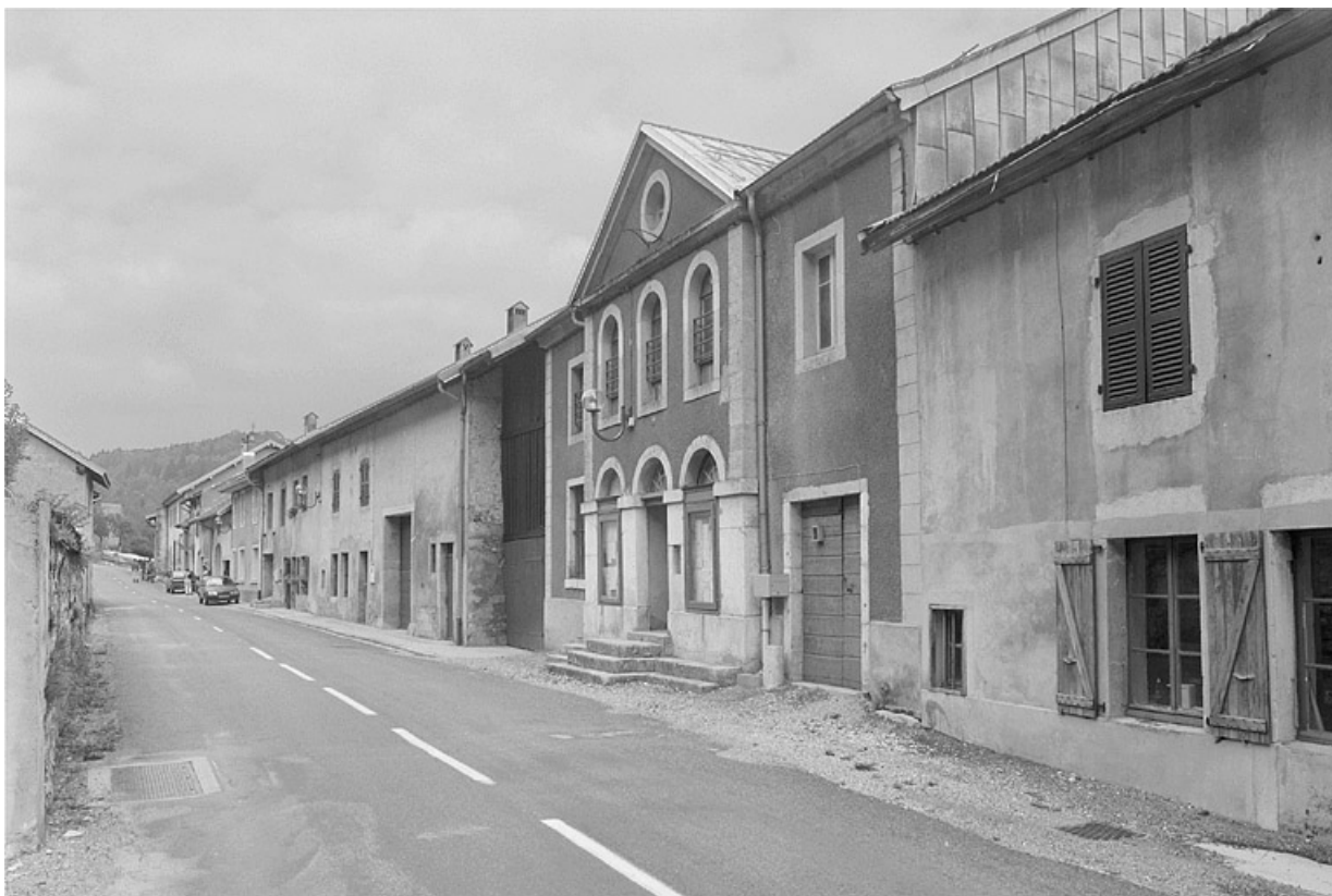
Vue depuis la rue principale.
