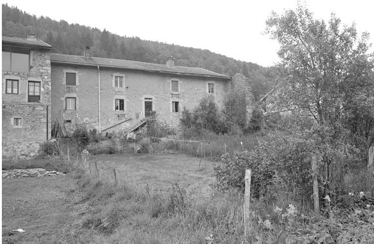
Façade postérieure, vue générale.
