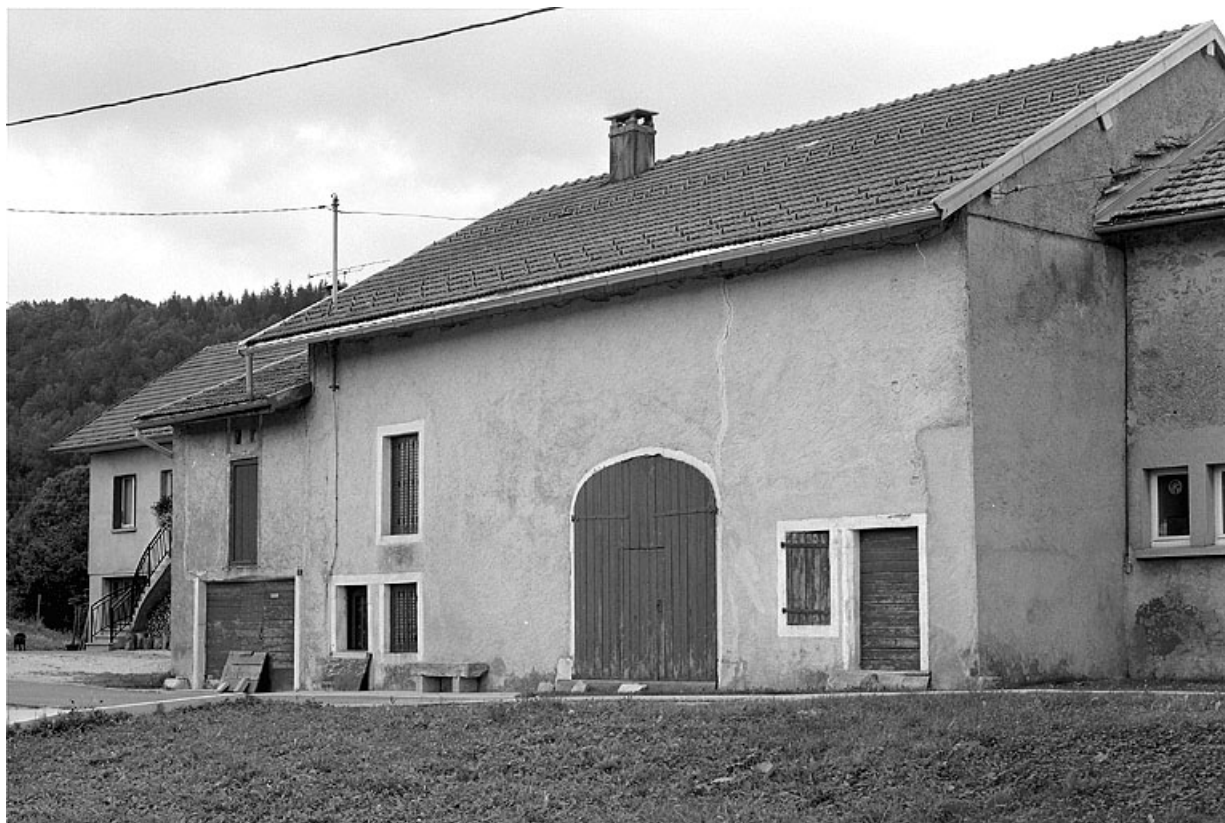
Façade sur rue avec les entrées du logis, de la grange et de l'étable.
