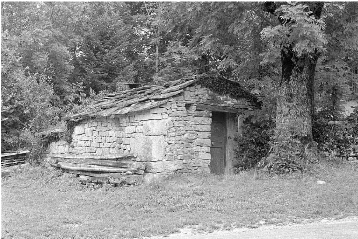
Fornil couvert en pierres calcaires.
