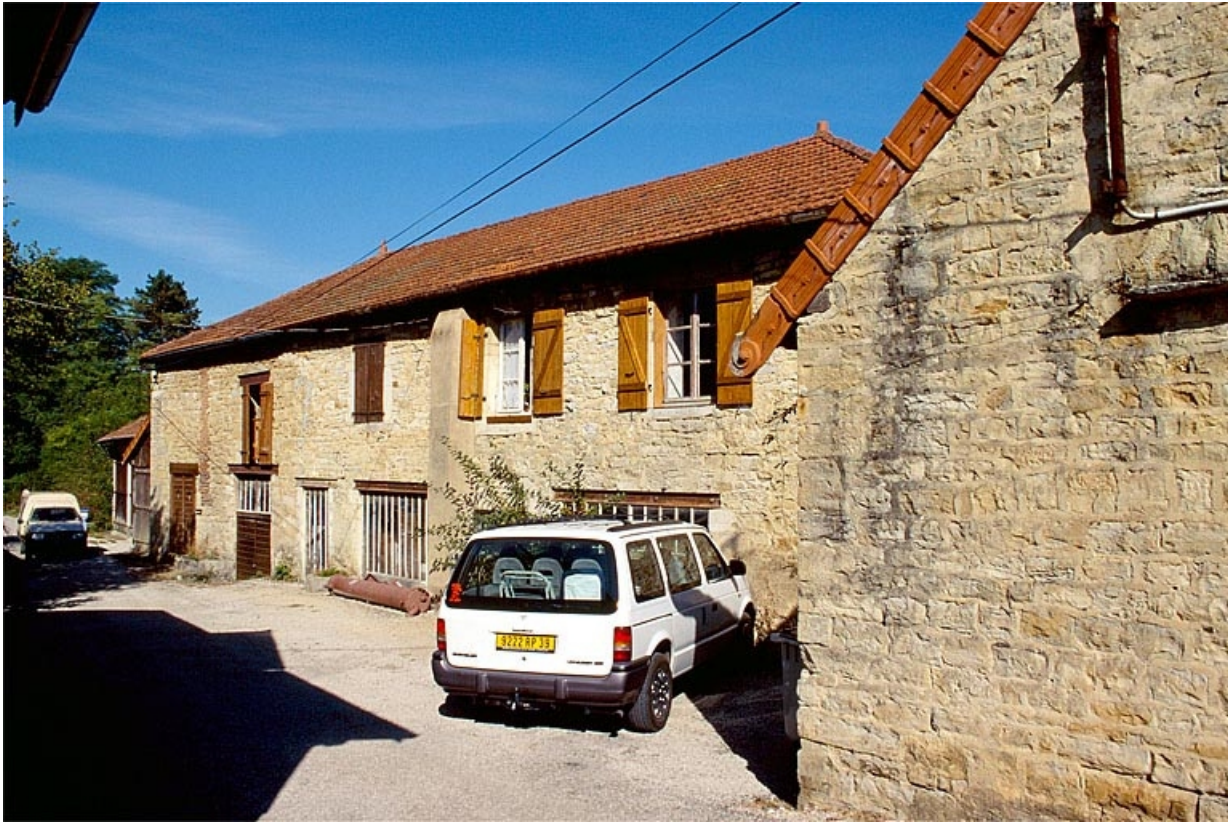
Atelier de fabrication et mur ouest du fournil.
