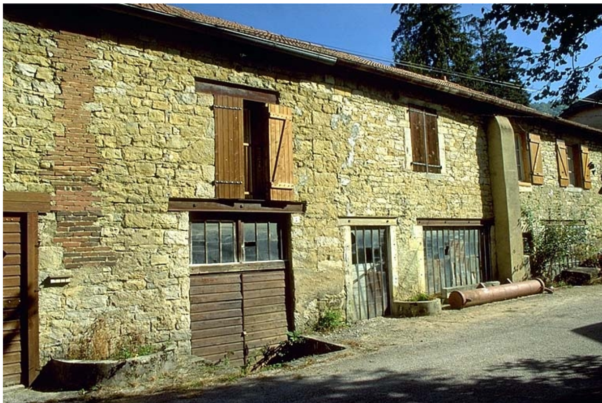
Façade antérieure de l'atelier de fabrication.
