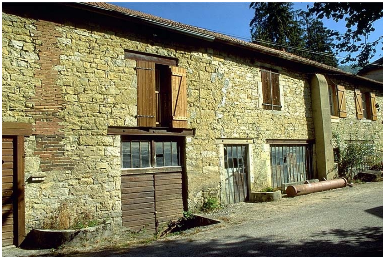
Façade antérieure de l'atelier de fabrication.
