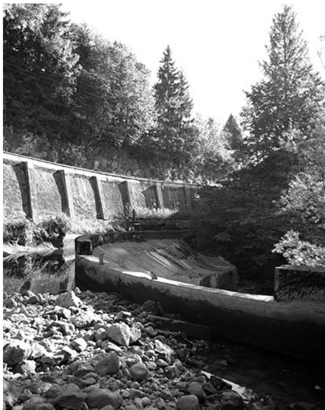
Bassin de retenue (à sec) et barrage.
