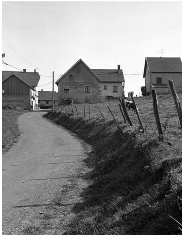
Atelier de fabrication et logement depuis le nord-ouest.
